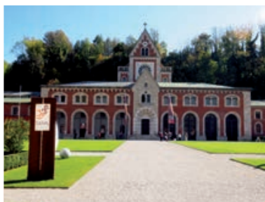
In der alten Saline ist die Pumpstation für die Sole.
